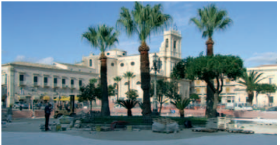
Piazza Umberto I, lavori in corso
