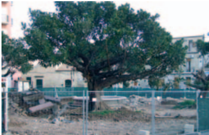
Piazza Trieste, lavori in corso
