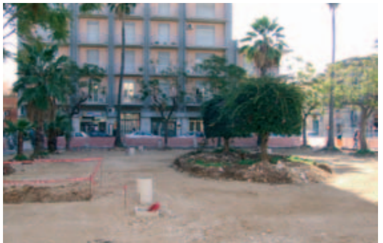
Piazza Teatro, lavori in corso
